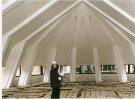
20 地上9mに張り囲らされた足場とはめこみ予定の空間。
