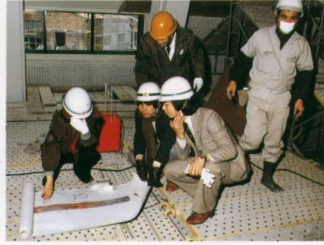
19 足場の上で作家は設計者、作業員とよく打合せをして下絵に従ってはめこみの準備をする。
