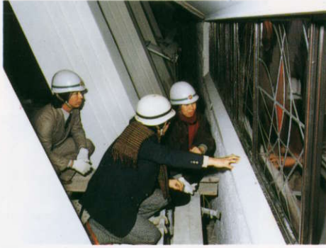
22 はめこまれたステンドグラスをコーキングし固定する。その後、固定の状況調べる。
